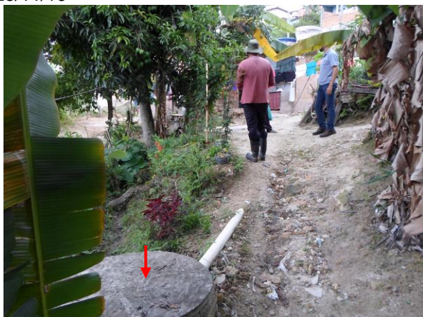
Foto 15: Presença de fossa negra no quintal de uma das residências na porção à montante da Mata da Caixinha. – 22/11/16
