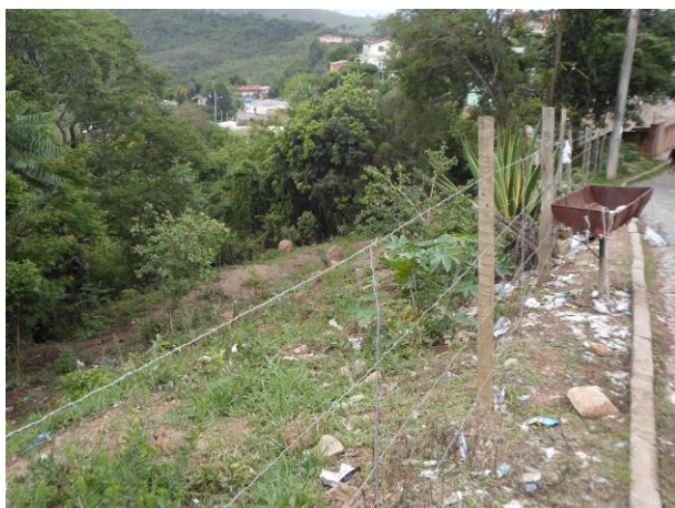
Foto 13: Vista do coletor de lixo e do cercamento da mata, em local confrontante com a via à montante. Presença de resíduos no entorno do coletor. – 25/11/16
