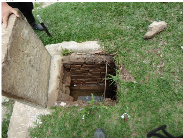
Foto 5: Reservatório de água proveniente da nascente da grota da Mata da Caixinha – 22/11/16
